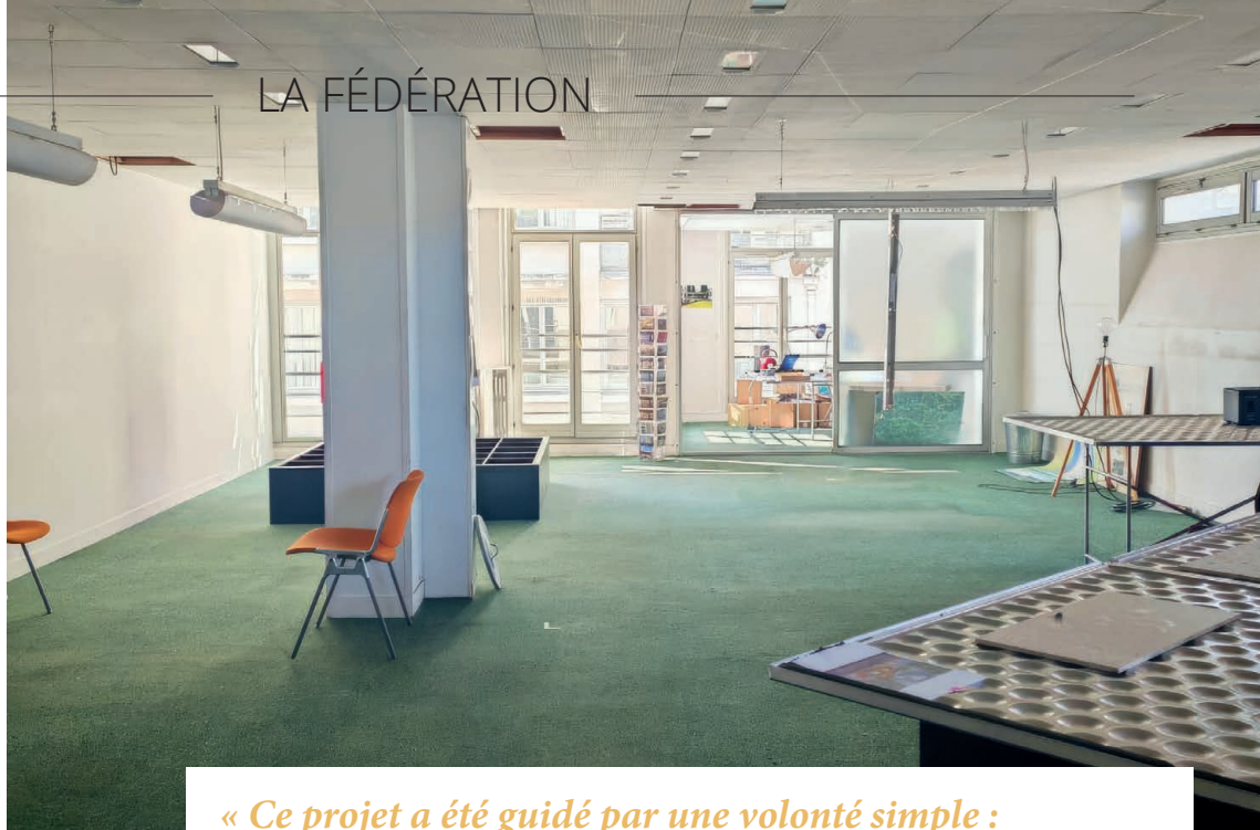
Photo avant travaux
